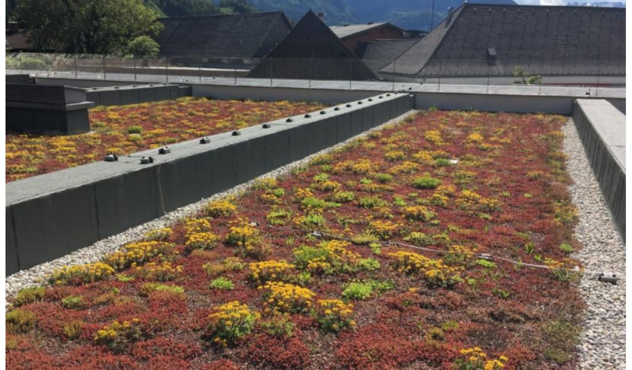
Fähigkeit zur Wasseraufnahme, Kühlung der Innenraumtemperatur bis 4°C, Dämmung und Puffer, Reduktion Wärmeeintrag
